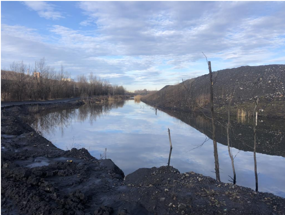
Vodní plocha podél hráze kalové nádrže „G“
